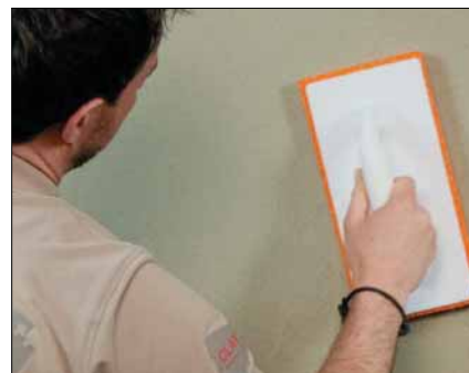
YOSIMA Lehm-Designputz wird in der Regel fein gerieben. Die Oberflächenbearbeitung soll mit nur wenig Wasser erfolgen.
