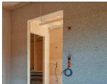
Aufbau in Holzrahmenbauweise, Innenbeplankung der Wände mit esb-Plus Holzbauplatten.
