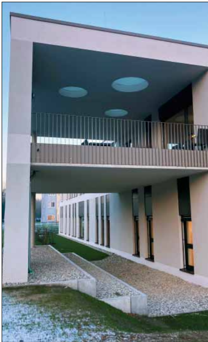
Die durchgängige Dämmung der Fassade vereinfacht Bauprozesse und minimiert Brandgefahren.
