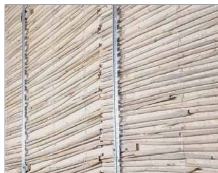
Anbringen von Rohrgewebe St 70 als Putzträger direkt auf die esb-Plus Platten.
