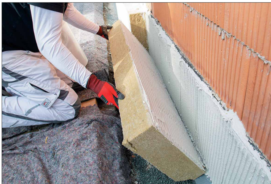
Das neue System ermöglicht erstmals, die komplette Fassade inklusive Sockel komplett mit Steinwolle zu dämmen.
