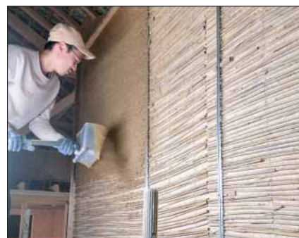
Maschinelles Aufbringen von ClayTec Lehm-Unterputz mit Stroh.
