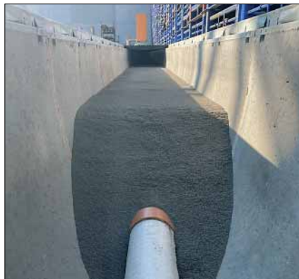
Filtersubstrat Carbotec 100 ermöglicht es, mehr Fläche an eine Filtersubstratrinne anzuschließen.
