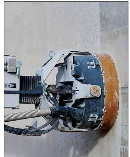
Mit der Schwamborn WDS 530 wurden 2.000 m 2 Wand in einer Woche gestockt.
