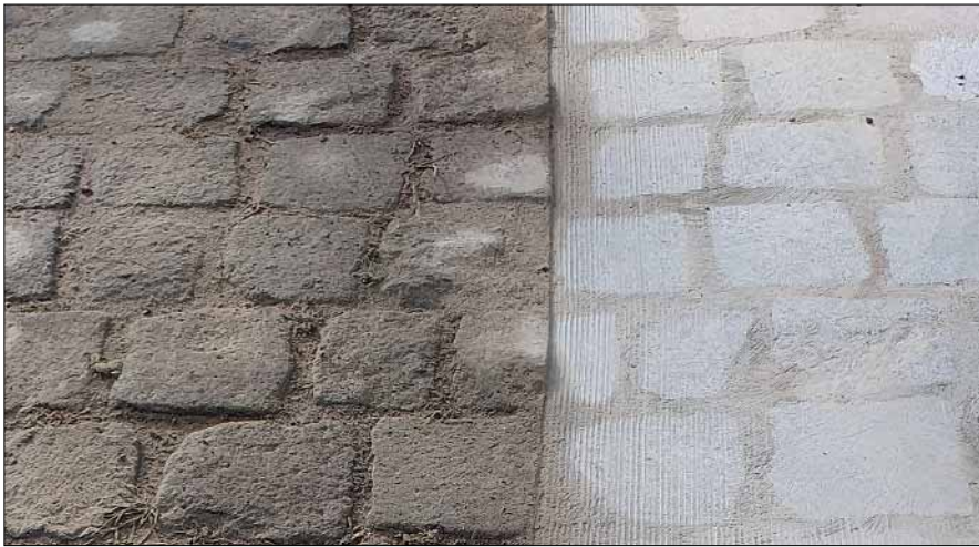
BEF 400RC: Die neue Fräs- und Schneidmaschine BEF 400RC ermöglicht das barrierefreie Einebnen von gepflasterten Wegen, Straßen und Plätzen. Links vor dem Einebnen, rechts danach ein barrierefreier Weg.
