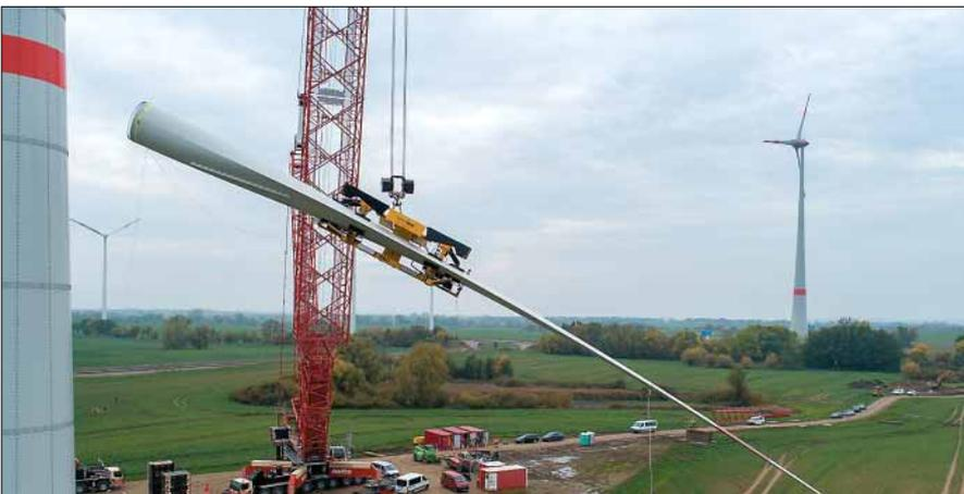
Die Rotorblatt-Traversen RBC-D50 von ematec sind weltweit im Einsatz.
