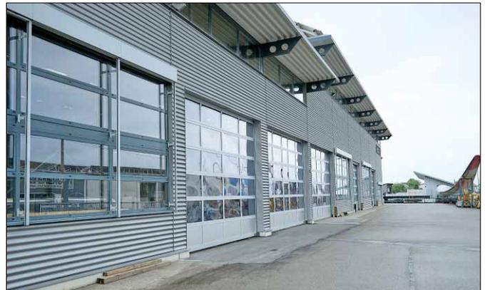
*Mit zusätzlichen Toren in der Haupthalle kann ematec die einzelnen Arbeitsplätze direkt von außen über die Hallentore bedienen.*
