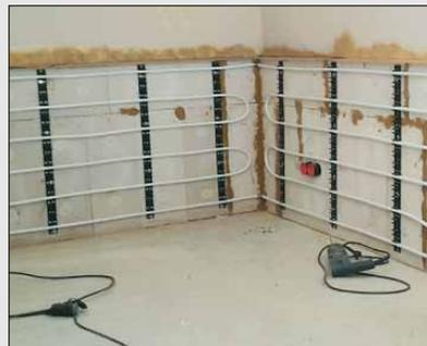
Ein besonderer Trick besteht darin, dass das System zu einem Wandheizsystem erweitert werden kann. Gerade in Räumen mit feuchtem Mauerwerk und aufsteigendem Wasser hat sich die eiwa arret isoklimaplatte über Jahre bewährt.
