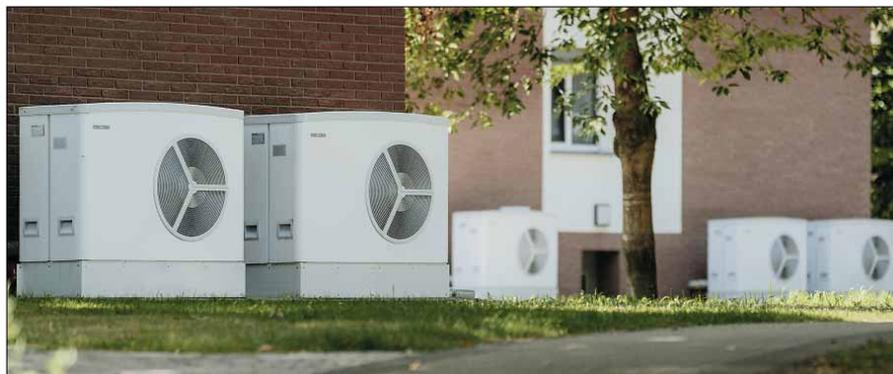
*Jeweils drei kaskadierte invertergeregelte Luft-Wasser-Wärmepumpen vom Typ Stiebel Eltron WPL 25 A versorgen die Häuser mit Wärme.*
