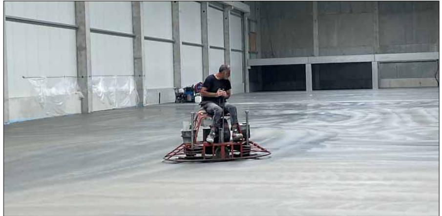
*Neodur HE 3 green lässt sich genauso einfach verarbeiten wie herkömmliche Einstreuprodukte. Nach dem Einstreuen wird das aufgebrauchte Material zunächst eingerieben und anschließend geglättet, in diesem Fall mit einer Doppelglättmaschine.*
