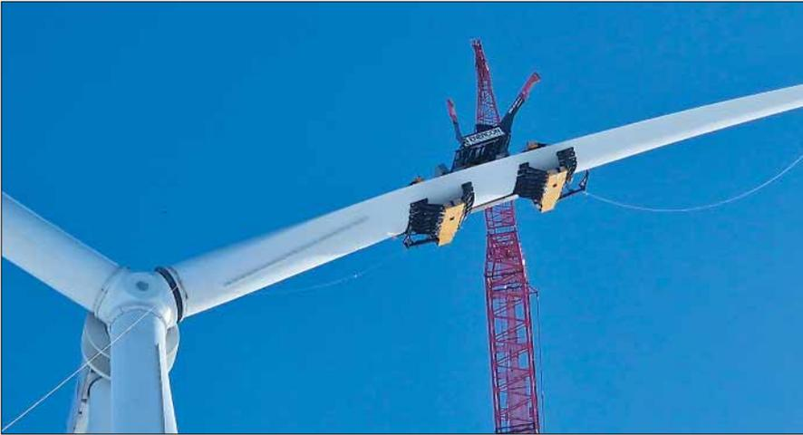
Mit den RBC-D-Traversen hat ematec die Montage von Rotorblättern revolutioniert.
