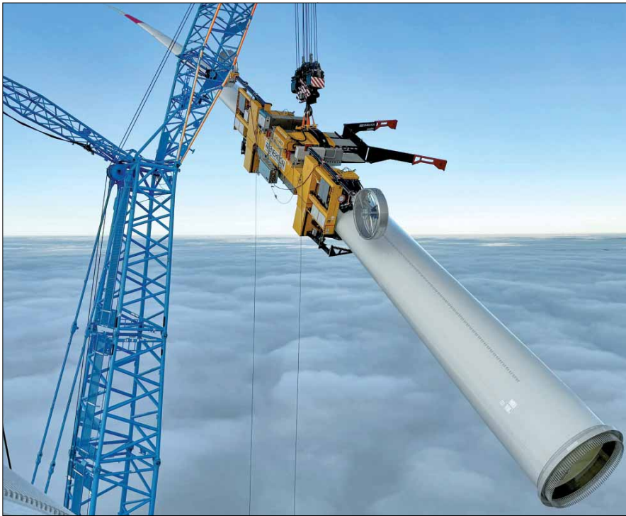
Mit den Rotorblatttraversen vom Typ RBC-D von ematec lassen sich Rotorblätter besonders sicher und schnell montieren.
