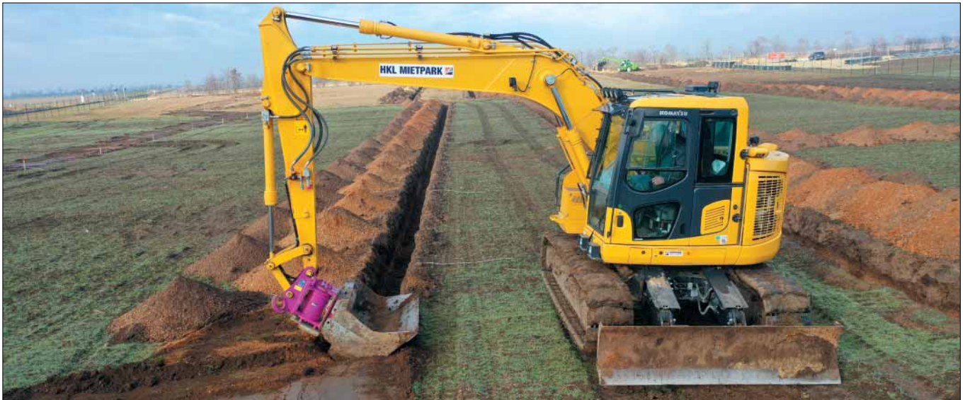
Ein Bagger aus dem HKL Mietpark wurde beim Ziehen von Leitungsgräben eingesetzt.
