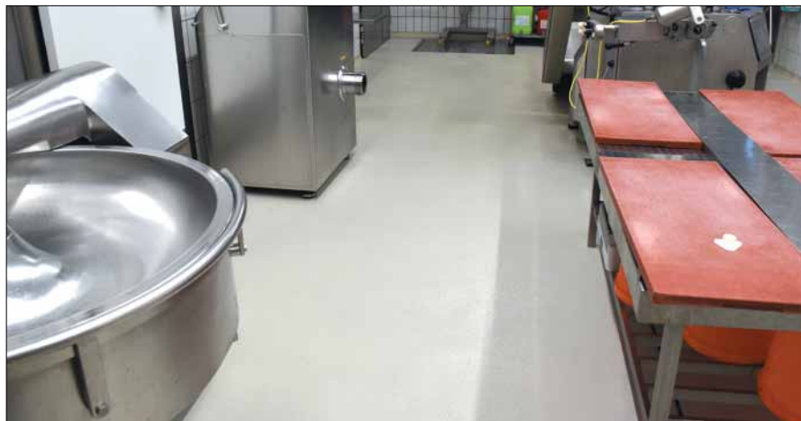
Für den Boden in der Wurstgarküche setzen die Betreiber auf das rissüberbrückende Beschichtungssystem StoFloor Industry Elastic WHG Deck 100.
