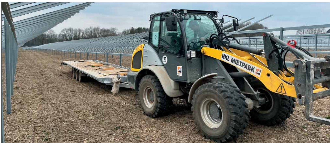
Ein eigens umgerüsteter Radlader mit Kugelkopfkupplung kam beim Transport von Materialien zum Einsatz.
