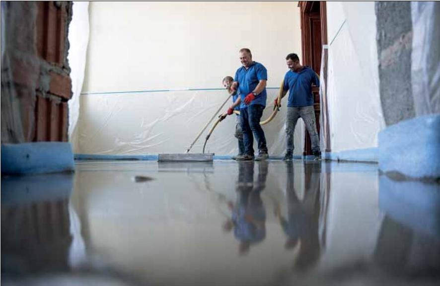
Systemlösungen für Flächenheizungen können mit Estrich- und Dünnestrichsystemen, Schnellzementestrich oder dem UZIN Turbolight System eingebaut werden je nach möglichem Flächengewicht, Punktlasten und Tragfähigkeit. Sie passen sich an unterschiedliche Baustellenszenarien und Renovierungsprojekte an.
