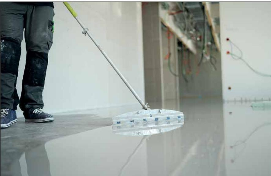
Die Spachtelmassen und Dünnestrichsysteme der Reihe UZIN FusionTec besitzen einen idealen Verlauf, sehr gute Konsistenz und erreichen schnell die nötige Belegreife.
