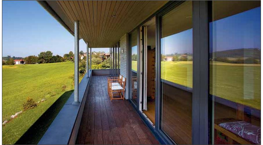
Zur Gestaltung moderner Glasarchitektur eignet sich bei Fenstern und Hebe-Schiebe-Türen die Kombination Aluminium-Holz oder Aluminium-Kunststoff – ein bodengleicher Übergang ohne Schrägen erhöht den Komfort.
