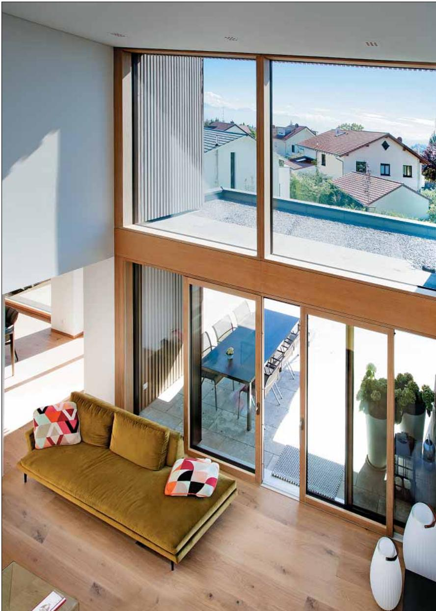
*Eine Besonderheit ist die Hebe-Schiebe-Tür »115 Sky Plus«, die rahmenlos in Pfosten-Riegel-Fassaden integrierbar ist.*
