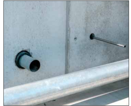
Notentwässerung über Speier.
