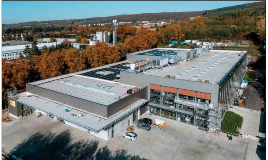
Blick auf die neue Halle von KWS in Einbeck.
