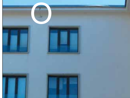
Messstelle am Dach.
