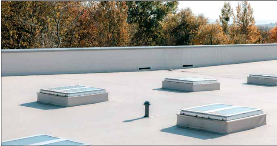
Über das Dach gelangt auch Tageslicht in die Halle – die Abläufe für die Hauptentwässerung sind sauber in die Fläche eingebunden.
