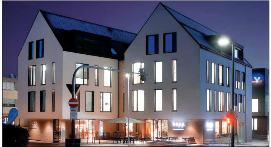
Der Erweiterungs-Neubau der Volksbank Laichingen Alb e.G. mit Büroflächen, zwei Wohnungen unterm Dach und der Bäckerei mit Café im Erdgeschoss am neugestalteten Vorplatz markiert das »neue Tor zur Innenstadt«.
