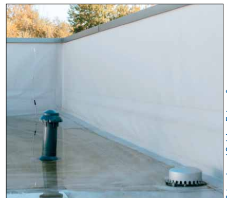
Einige Entwässerungspunkte liegen nahe der Attika.
