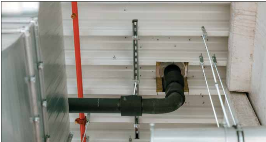
Die Entwässerung läuft unter dem Hallendach über Sammelleitungen als Druckentwässerung in schmalen Röhren (DN 70). (Die roten Leitungen sind Sprinkler für den Brandschutz.)
