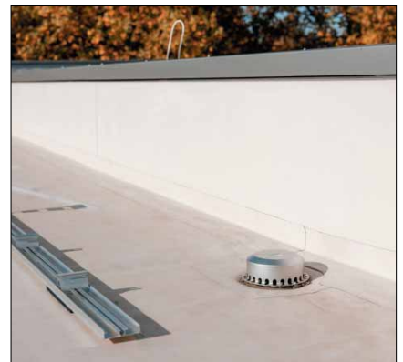
Einige Entwässerungspunkte liegen nahe der Attika.
