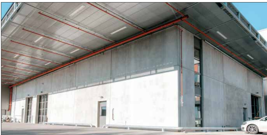
Der weite Dachüberstand bietet auch vor der Halle Schutz.
