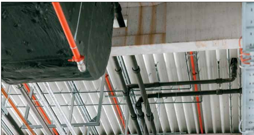
Die Entwässerung läuft unter dem Hallendach über Sammelleitungen als Druckentwässerung in schmalen Röhren (DN 70). (Die roten Leitungen sind Sprinkler für den Brandschutz.)
