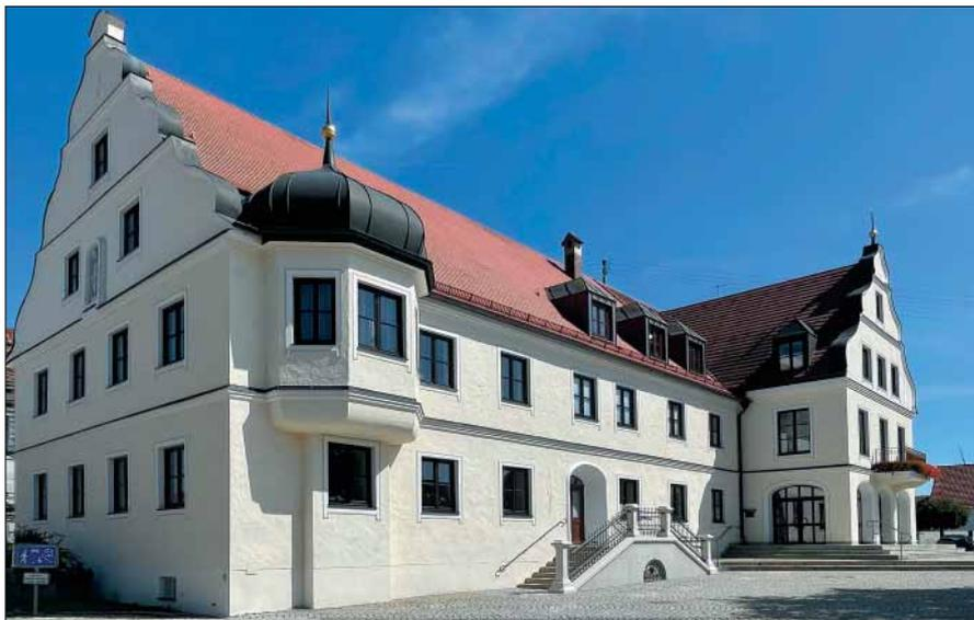
*Das historische Rathaus litt unter erheblichen Bauschäden. Gegen saugende, aufsteigende Feuchtigkeit erfolgte der Einbau einer nachträglichen Horizontalsperre im Bohrlochverfahren.*
