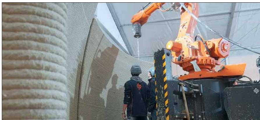
Schicht für Schicht entstehen die Wände und Säulen. Bei dieser Bauweise werden keine Schalungen benötigt. Die Rezeptur des Baustoffs CyBe Mortar von Korodur wurde präzise auf die Anforderungen des 3D-Druckens abgestimmt.
