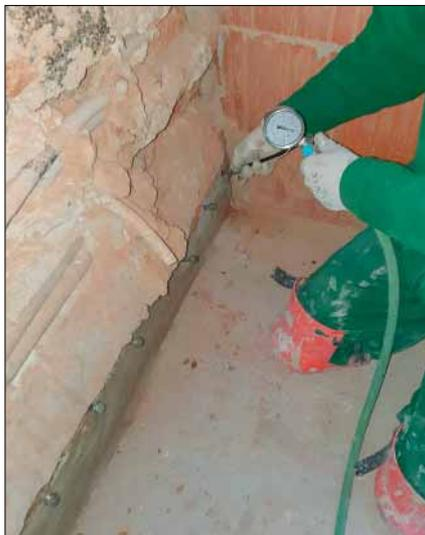
*Der Einbau der Horizontalsperre erfolgte an den gesamten Umfassungswänden auf über 53 lfm und in Teilbereichen von neu eingezogenen Zwischenwänden.*
