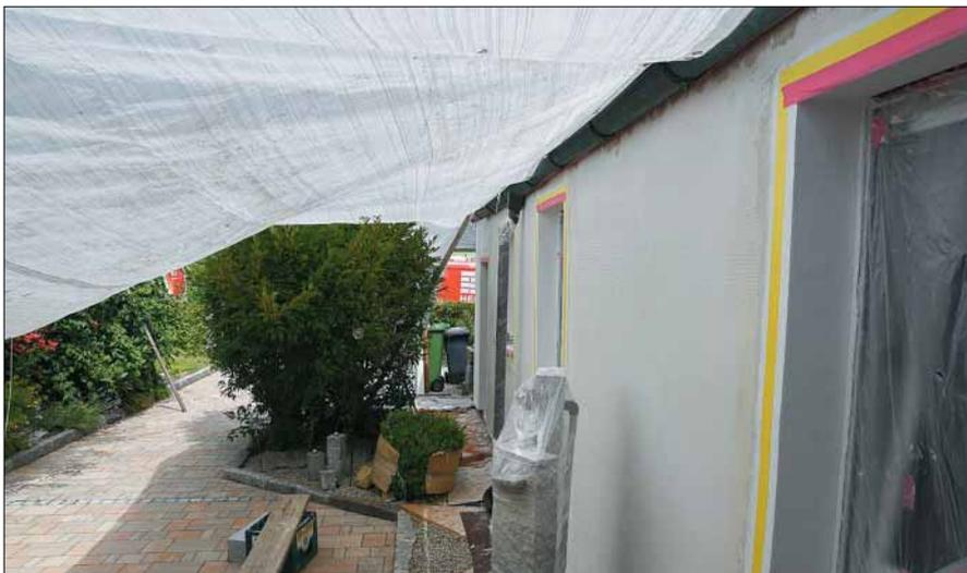
Das A und O bei hohen Temperaturen ist das fachgerechte Vornässen sowie die Grundierung des Untergrunds. Eine Plane bringt Schatten und schützt vor trockenem Wind.
