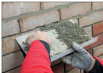
*Der Fugenmörtel wird oft unterschätzt, ist aber ein entscheidender Faktor für die Optik und Dauerhaftigkeit eines Klinker-WDVS.*
