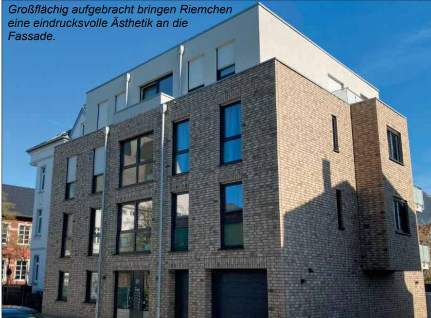
Klinkerriemchen und keramische Beläge zeichnen sich bei der Fassadengestaltung durch ihre ansprechende Ästhetik, Langlebigkeit und Widerstandsfähigkeit aus. Sie bieten zudem eine riesige Auswahl an Farben und Oberflächenstrukturen. Mit keramischen Riemchen auf einem Wärmedämmverbundsystem (WDVS) mit Steinwolle-Aufbau lassen sich beeindruckende Fassadengestaltungen realisieren – bei maximalem Brandschutz.
