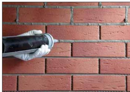
*HECK Fugenmörtel, hier im Bild die spritzfähige Variante, unterstützen durch hohe Witterungsbeständigkeit die Langlebigkeit der Fassade.*
