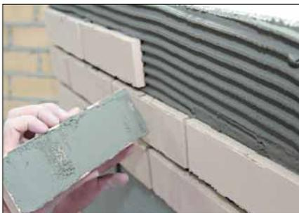
*Die Riemchen werden im sogenannten Buttering-Floating-Verfahren verklebt. Dabei wird Klebmörtel auf den Untergrund und den Belag aufgetragen und das Riemchen anschließend eingeschwommen.*
