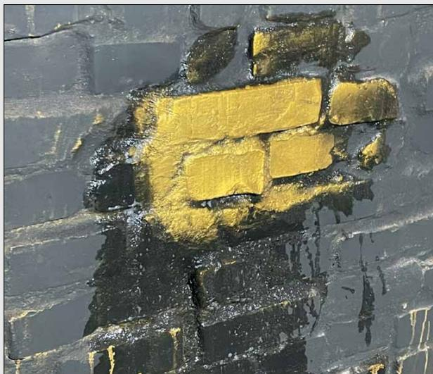
*Im ersten Schritt wurde die gesamte Oberfläche mittels HEPA-Staubsauger gereinigt. Eine kurze Testreinigung zeigte auf, welches Reinigungsmittel Verwendung findet.*
