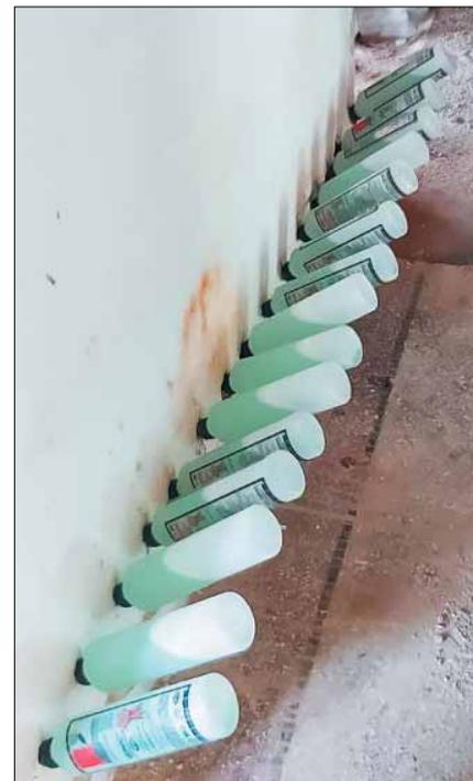
Insgesamt wurden ca. 30 lfm Vollziegelmauern mit Wanddicken von 30-50 cm trocken gelegt.
