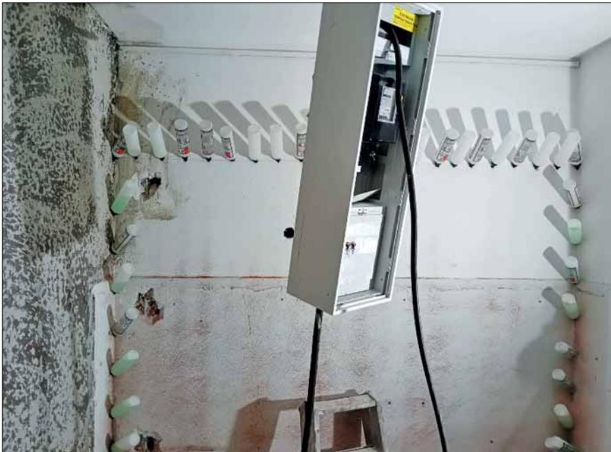
Anbringen der Horizontal- und Vertikalsperre über Vorratsbehälter ohne Druck.
