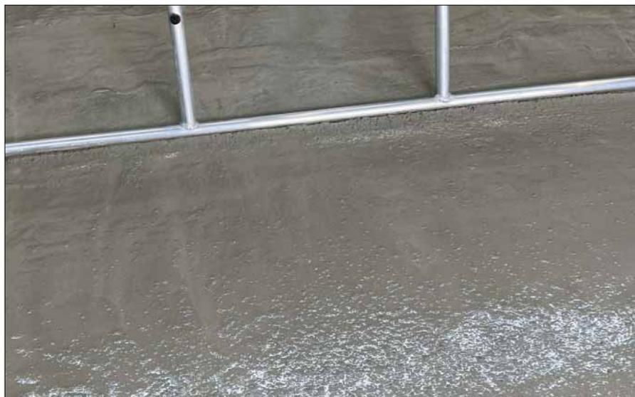
*StoCrete TG 302 lässt sich mit Schwabbelstange oder Estrichverteiler knie- und rückschonend im Stehen nivellieren und verdichten.*
