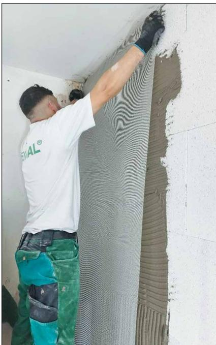
Aufbringen des Armierungsgewebes auf die Veinal ExsalTherm-Platten, die Wärmedämmung und Feuchteschutz zugleich sind.
