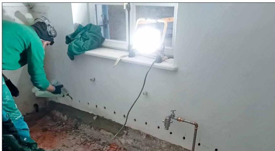
Zunächst wurde an allen Außenmauern eine Horizontalsperre gegen saugende, aufsteigende Feuchtigkeit durch drucklose Applikation im Bohrlochverfahren eingebaut. (Bild: Andreas Mühlbauer)
