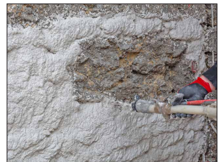
Bei Bedarf wird eine zweite Lage aufgebracht.
