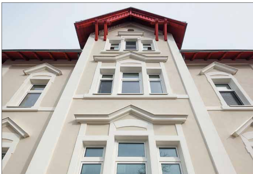
Die detailreiche Fassade galt es von Grund auf neu aufzubauen. Die Flächen armierte die Firma Reiss mit Gittermatten und Multimörtel. Sämtliche Anschlussstellen bearbeiteten die Profis mit Anputzleisten, Putzabschluss- und Blechanschlussprofilen. Laibungen, Lisenen und Faschen beschichteten sie mit Kieselit-Streichvlies.
