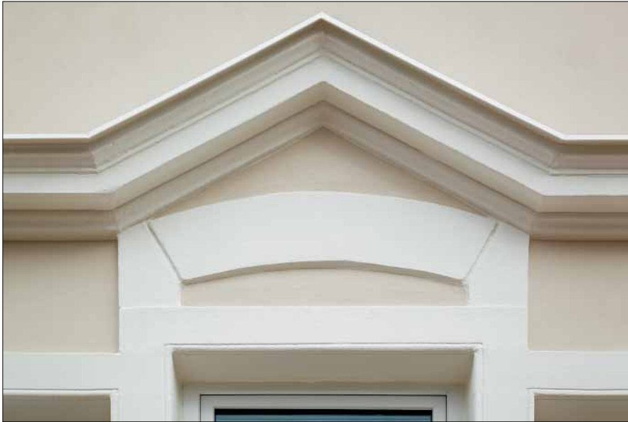
Hochqualitative Ausführung: Nach vorheriger Grundierung mit Kieselit Grundiermittel erfolgte die Endbeschichtung mit Kieselit Fassadenfarbe. Als mineralisches System eignet sich Kieselit besonders gut für die Bearbeitung historischer Fassaden.
