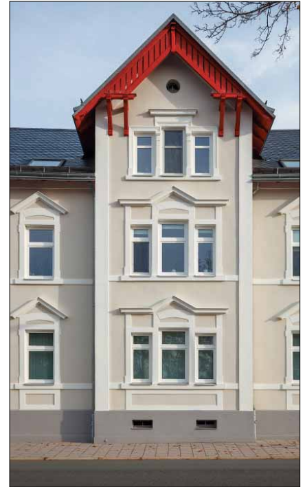
Auftraggeber Peter Schödel erhält viele positive Rückmeldungen auf die gelungene Sanierung.
