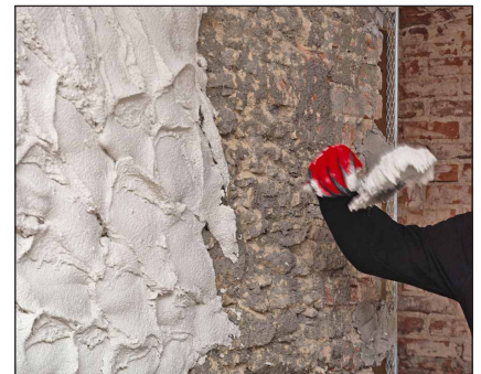
Aufbringen des Sanierputzes von Hand in gleichmäßiger Putzdicke.
