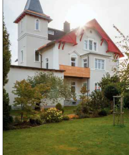
Jetzt strahlt er wieder: Der Altbau von 1887 hat nach einer misslungenen Renovierung vor einigen Jahren nun eine schöne und langlebige Fassade erhalten.
