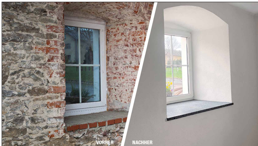
Doppelter Schutz: Sanierputze leiten Feuchtigkeit aus dem Mauerwerk an die Oberfläche und verhindern Salzablagerungen auf der Oberfläche.
