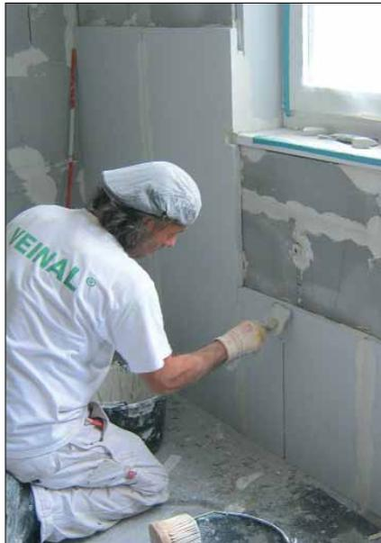
Vor der Montage muss sichergestellt sein, dass die Untergründe sowie die Wandoberflächen geeignet und frei von Pilzbefall sind bzw. entsprechend vorbehandelt werden.
