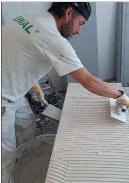
Die Wohnklimaplaten werden mit einem mineralischen Spezialkleber an der Wandinnenseite aufgebracht.
