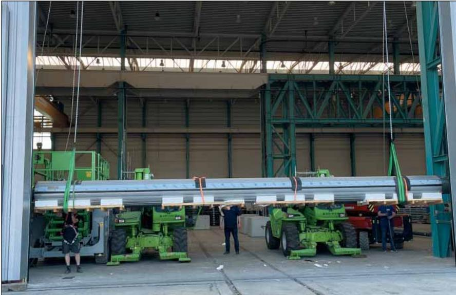
Montage mit zwei Teleskopstaplern und Hubarbeitsbühnen.
