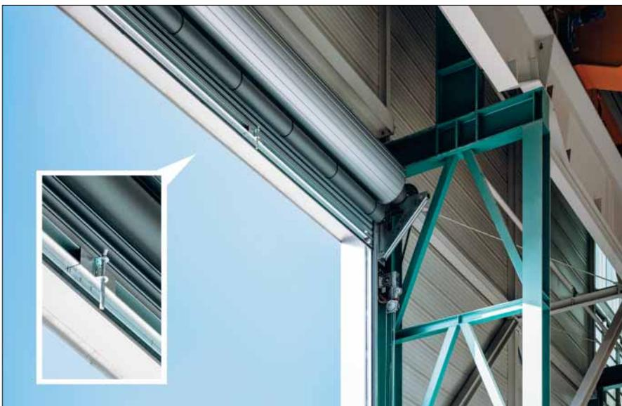
Die Andrückwelle hält den Behang in der richtigen Position, die Bodenanker sind eine individuelle Sonderlösung. Alle Maßnahmen sorgen dafür, die geforderte Produktnorm für ein derart dimensioniertes Tor zu erfüllen.
