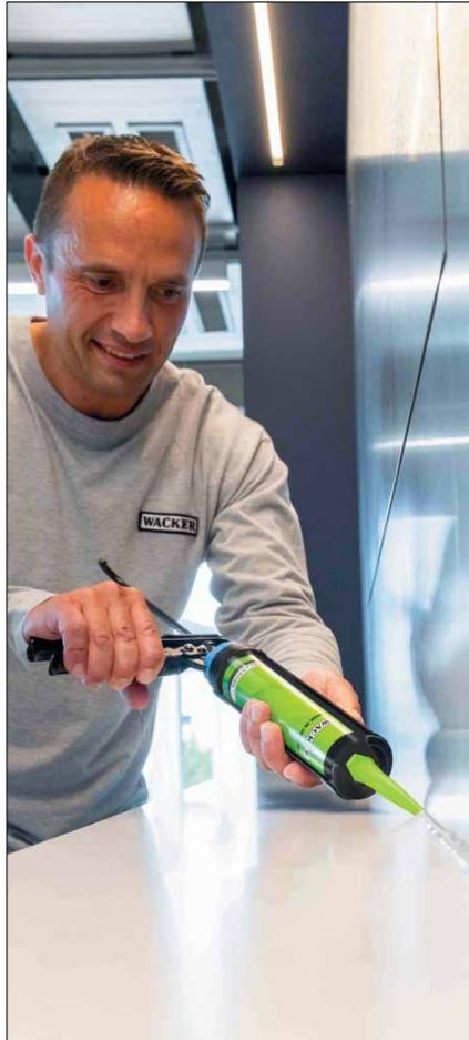
*ELASTOSIL® eco 7770 P dringt dank eines speziellen Siliconweichmachers nicht in die Poren von Marmor, Granit oder Sandstein ein. Der Naturstein bleibt dadurch makellos.*
