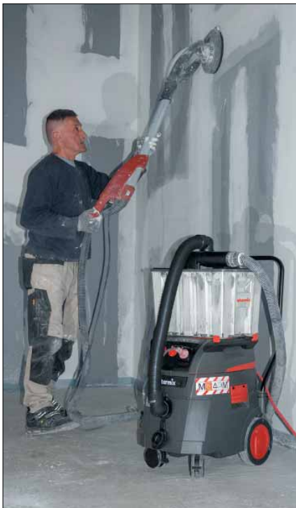
Der Dustfixx ist ein Vorabscheider für staubintensive Arbeiten, hier mit einem Sauger aus der starmix iPulse-Reihe mit Giraffe.
