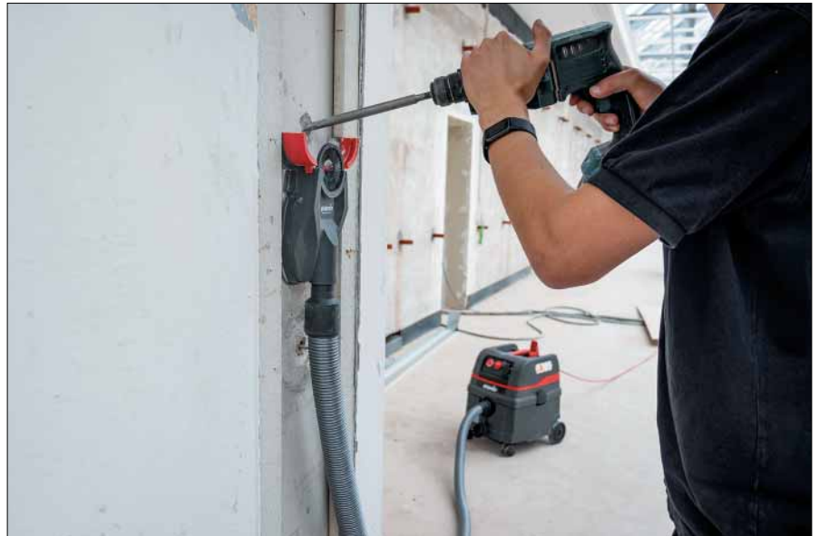
Mit dem Bohrfixx 60 Plus können Bohr- und Schleifarbeiten auch ohne Hilfe staubfrei erledigt werden.
