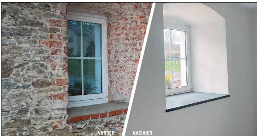
Sanierputze leiten Feuchtigkeit aus dem Mauerwerk an die Oberfläche und verhindern Salzablagerungen auf der Oberfläche.
