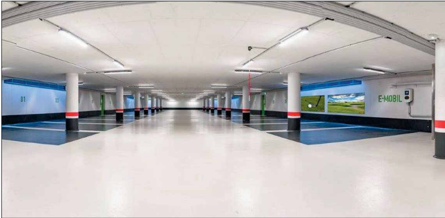
Tiefgarage Reverie Berlin-Zehlendorf.
