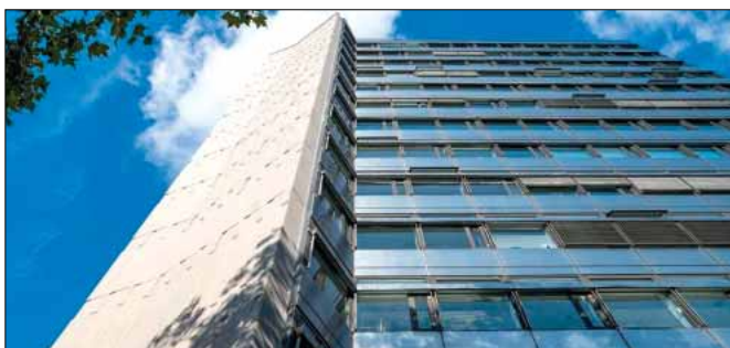
Betongiebel-Instandsetzung vom denkmalgeschützten Dorlandhaus in Berlin.
