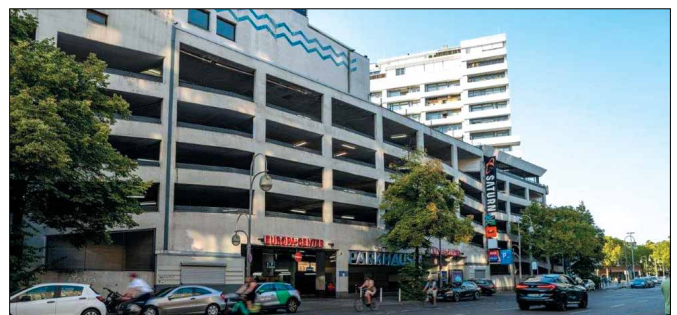
Beschichtungen der Betonkonstruktion im Parkhaus vom Europa Center in Berlin.
