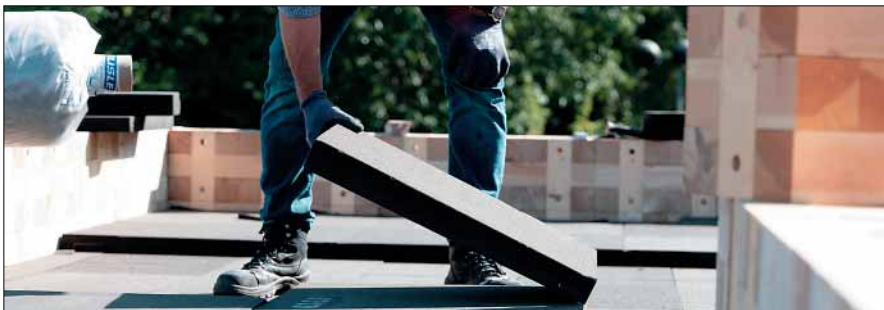
Simpel und reuse-fähig: Das lose verlegte Schaumglasdach ist absolut klebstofffrei und komplett wiederverwendbar.
