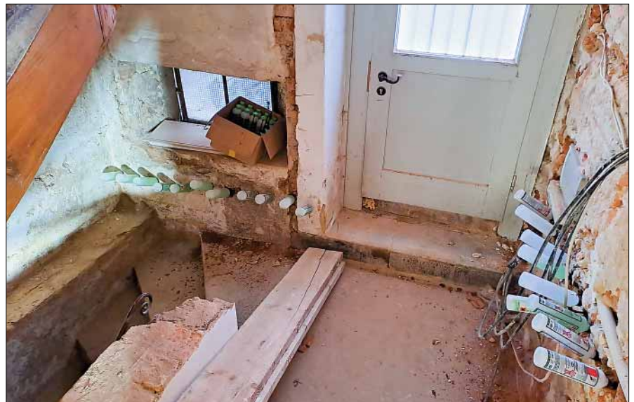
Die extrem kriechfähige Silikonharzlösung reagiert mit der Feuchtigkeit im Mauerinneren und bildet in kurzer Zeit eine unverrottbare Schicht aus polymerem Silikonharz.
