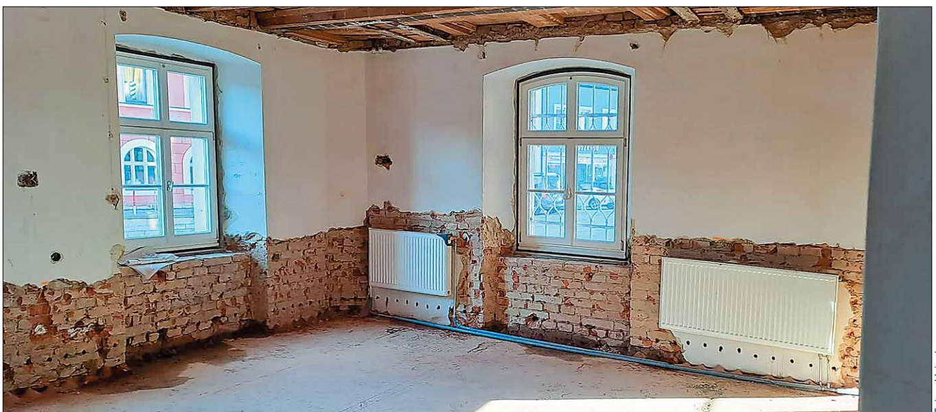
Der Einbau einer durchgehenden nachträglichen Sperre gegen saugende, aufsteigende Feuchtigkeit über den kompletten Mauerquerschnitt erfolgte durch drucklose Applikation der Silikonharzlösung im Bohrlochverfahren.
