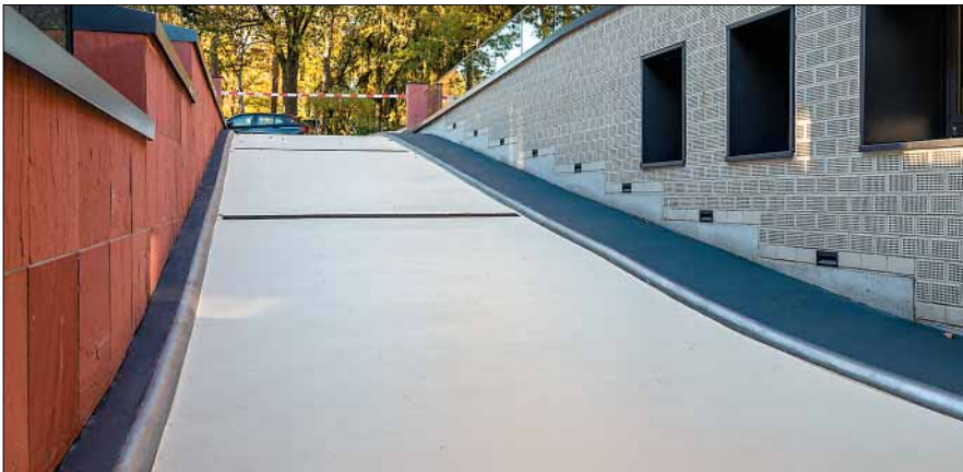
Zufahrt zur Tiefgarage Reverie Berlin-Zehlendorf.
