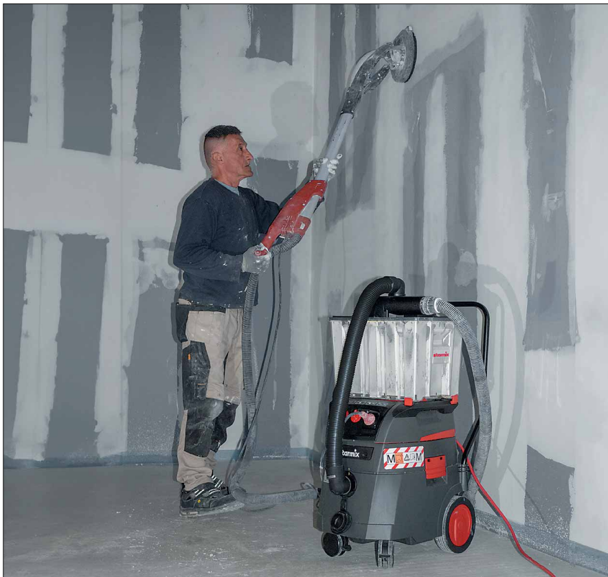
Der Dustfixx ist ein Vorabscheider für staubintensive Arbeiten. Hier mit einem starmix iPulse mit Giraffe.
