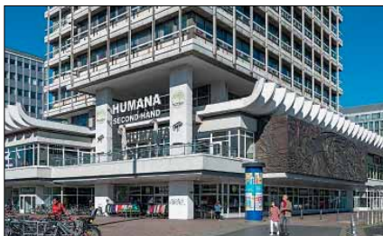
Betoninstandsetzungen am »Haus des Reisens«, Berlin-Alexanderplatz.
