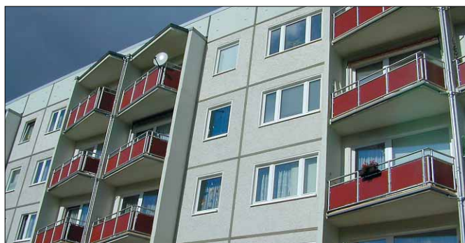
Plattenbausanierung in Arnstadt mit EUROTEK-Band.
