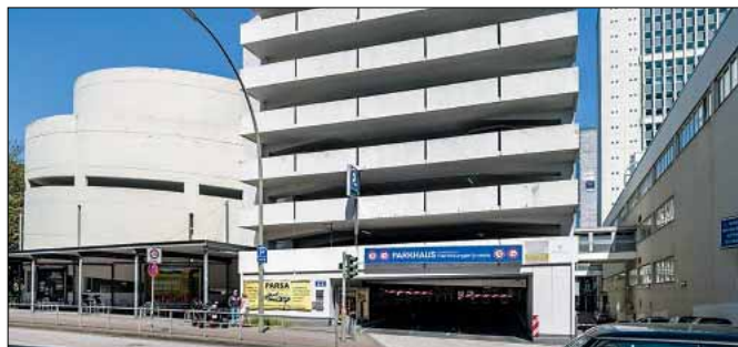
Betoninstandsetzungen und Beschichtungen in 2000, Contipark Parkhaus »Hamburger Meile«, Hamburgerstraße.
