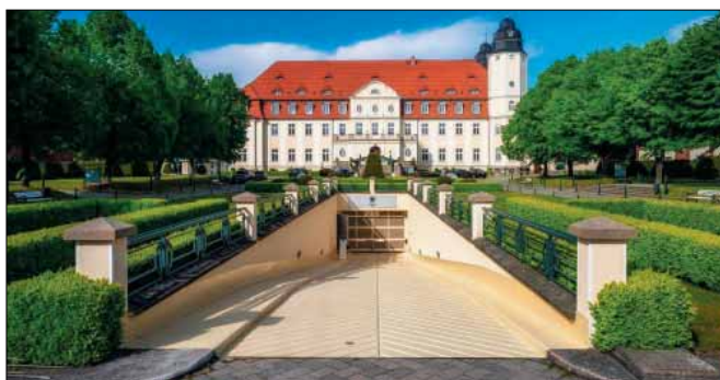
Sanierung der Tiefgarage, Schlosshotel Fleesensee.
