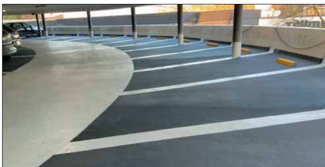
Polyurea-Beschichtungen in Mönchengladbach.
