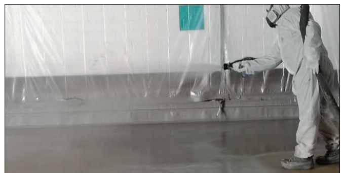
Polyurea-Abdichtung – Schutz der Betonflächen gegen Chloride.
