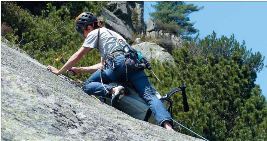
*Sicherer Halt am Abgrund: Bei der Montage von Bohrhaken am Gotthardpass kamen die fischer Bolzenanker FAZ II aus nichtrostendem Stahl (R) in 10 x 80 mm zum Einsatz. Mit diesen mechanischen Dübeln verankerten die Kletterer die 10-mm-Bohrhakenlaschen sicher und fest in den Felswänden.*
