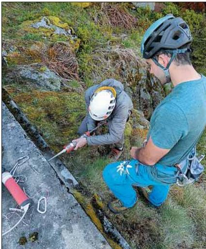
*Zur Montage der Klebehaken am Gotthardmassiv injizierten die Kletterer den fischer Injektionsmörtel FIS V 300 T mithilfe des zugehörigen fischer Auspressgeräts in das Bohrloch, drehten darin die Haken ein und verstrichen ausquellenden Restmörtel.*
