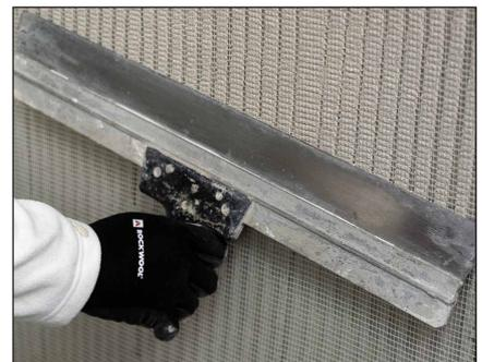
Der Armierungsmörtel wird in der endgültigen Schichtstärke aufgetragen und das Armierungsgewebe eingebettet.
