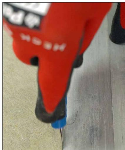
*Die Inneo-Innendämmplatte Heck Comfortrock ID kann einfach und tadellos mit einem Cuttermesser zugeschnitten werden.*
