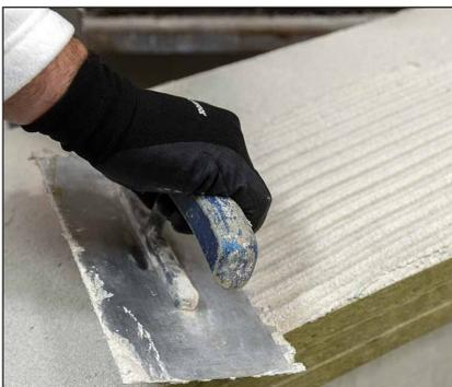
Der Kleber wird auf den Dämmplatten ohne Grundierung vollflächig mittels Zahntraufel aufgebracht. Außerdem wird der Klebemörtel vollflächig auf dem vorbereiteten Untergrund vorgezogen.
