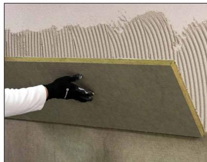
Anschließend die Dämmplatte am vorbereiteten Untergrund andrücken und einschwimmen. Es ist keine Verdübelung erforderlich.
