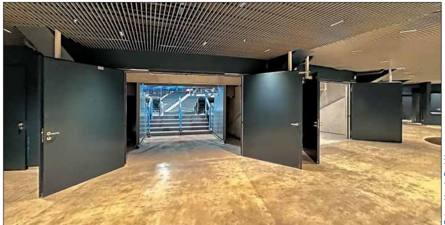
Ausgestattet mit einem effektiven Brand- und Rauchschutz (EI 230 -S 200 -C5) bieten diese Tore nicht nur zuverlässigen Schutz im Ernstfall, sondern sind auch mit einer Vielzahl funktionaler Merkmale ausgestattet.
