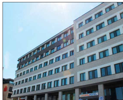
Ein zentraler Aspekt war die Aufstockung des Gebäudes bei gleichbleibender Grundfläche, um zusätzlichen Raum zu schaffen.
